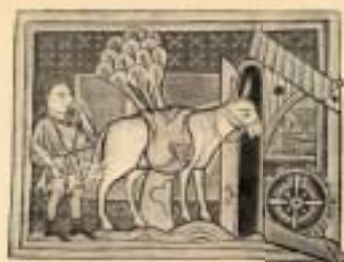
Рис. 66. Доставка зерна на водяную мельницу. Мельничное колесо подливного типа, под ним – деревянный желоб. Внутри мельницы – деревянная зубчатая передача, приводящая в движение жернова. Выше жерновов – бункер для зерна. Миниатюра из бестиария первой пол. XIII в., Англия, Бодлеянская библиотека, Оксфорд [7]
